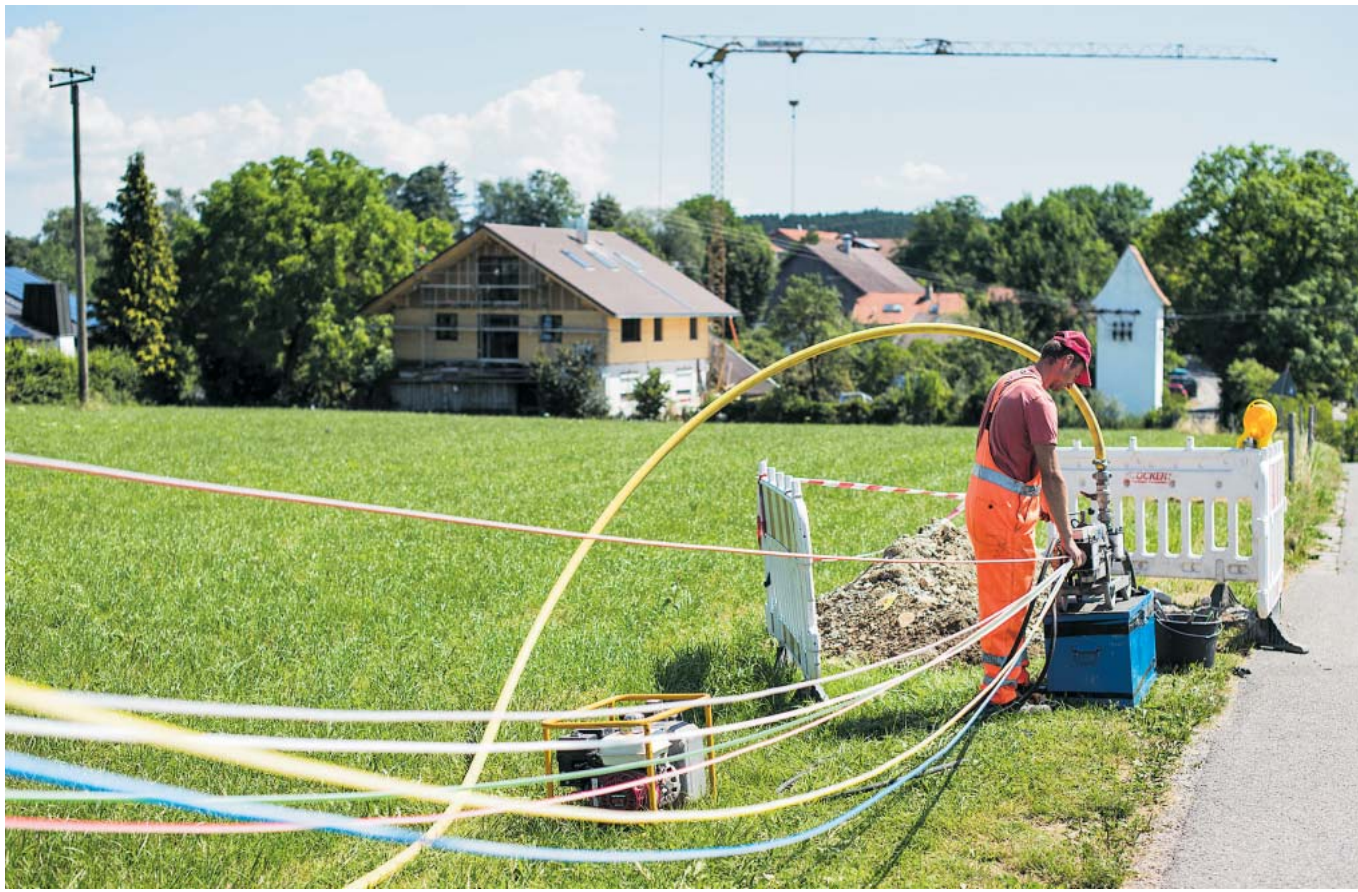
Ausbau jetzt: Ein Arbeiter verlegt im bayerischen Deggendorf Glasfaserkabel.
